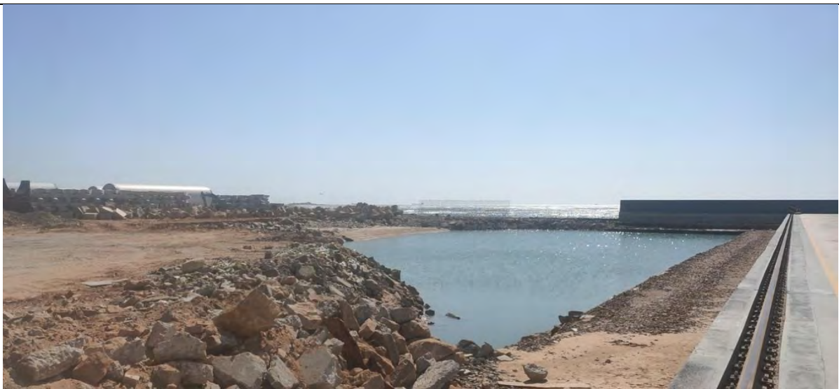
先建设驳岸再进行填海
