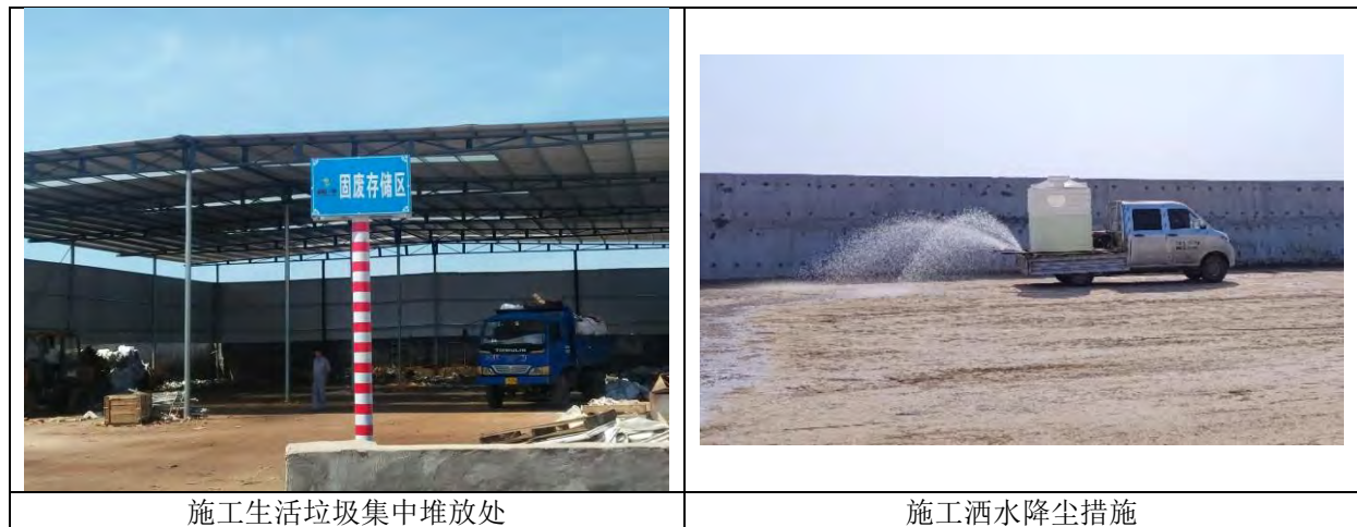
图 5.2-1 施工期环境保护措施照片
